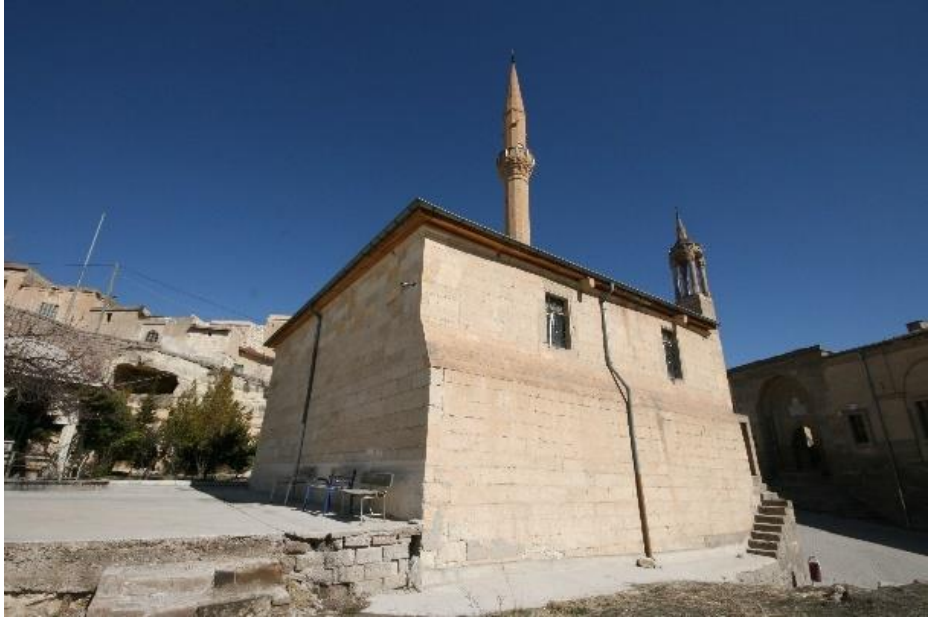
Foto 2. Mustafapaşa Cami-i Kebir'in Güneybatıdan Genel Görünümü
