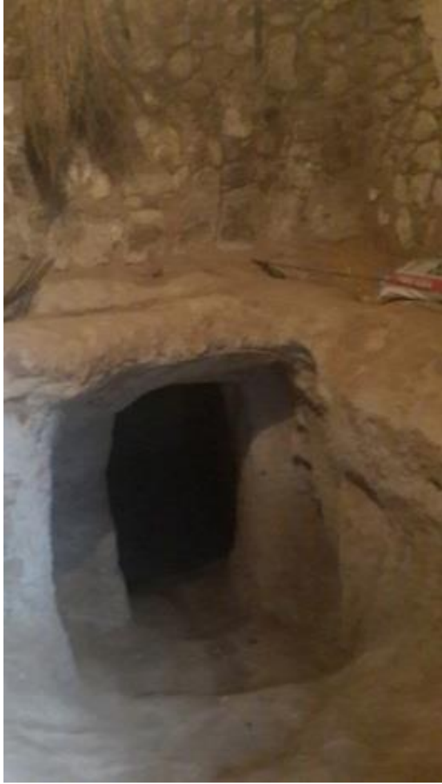
Şekil 9. Üzeri tonoz örtülü yığma tek katlı yapıdan kaya oyma mekâna geçiş (Efe Yavaşcan 2015).
