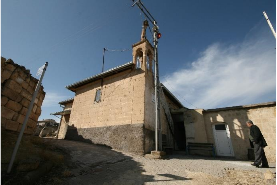
Foto 7. Mustafapaşa Sipahi Camisi'nin Güneydoğusundan Genel Görünüm
