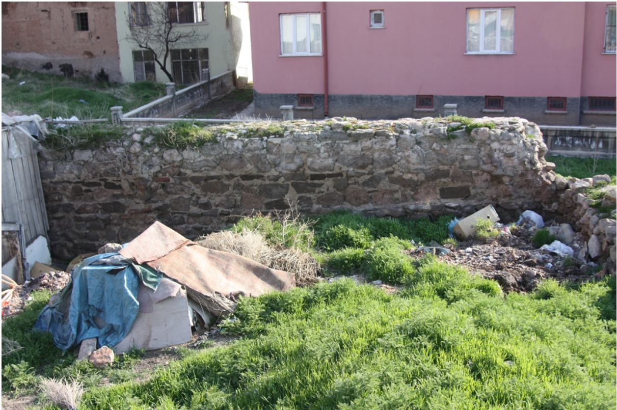
Resim 5 (Aksaray Darüşşifası Duvar kalıntısı) 5
