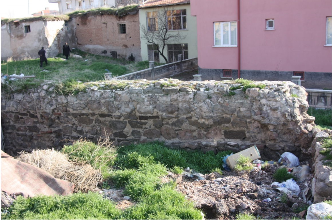
Resim 6 (Aksaray Darüşşifası Duvar kalıntısı) 6
