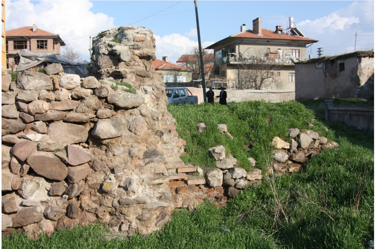
Resim 9 (Aksaray Darüşşifası Duvar kalıntısı) 9
