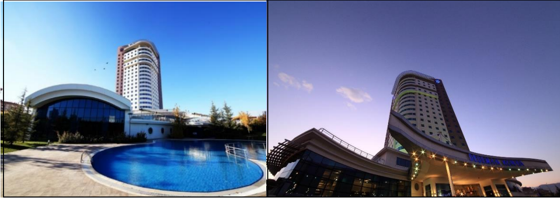
Şekil 2: Konya Dedeman Otel Binası Dış Cephe Görünümü
