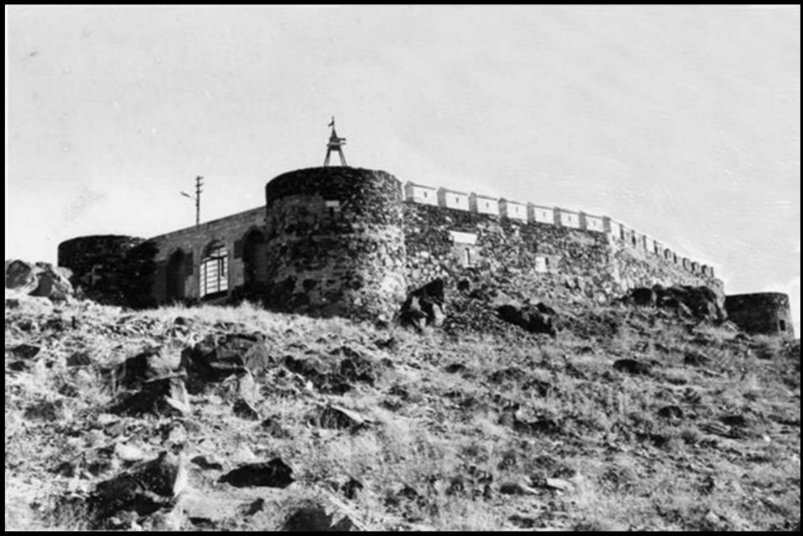
Şekil 11. Nevşehir Kalesi kuzey ve doğu cephesi (Nevşehir Belediyesi Kentsel Dönüşüm Müdürlüğü Arşivi)
