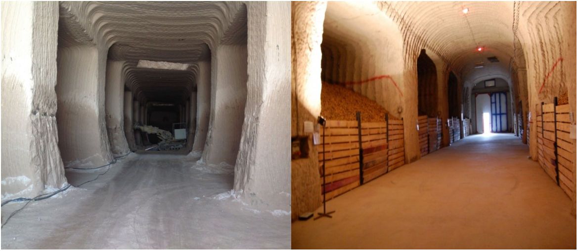
Şekil 1. Doğal soğutmalı yeraltı deposu (Anonim 2015)
