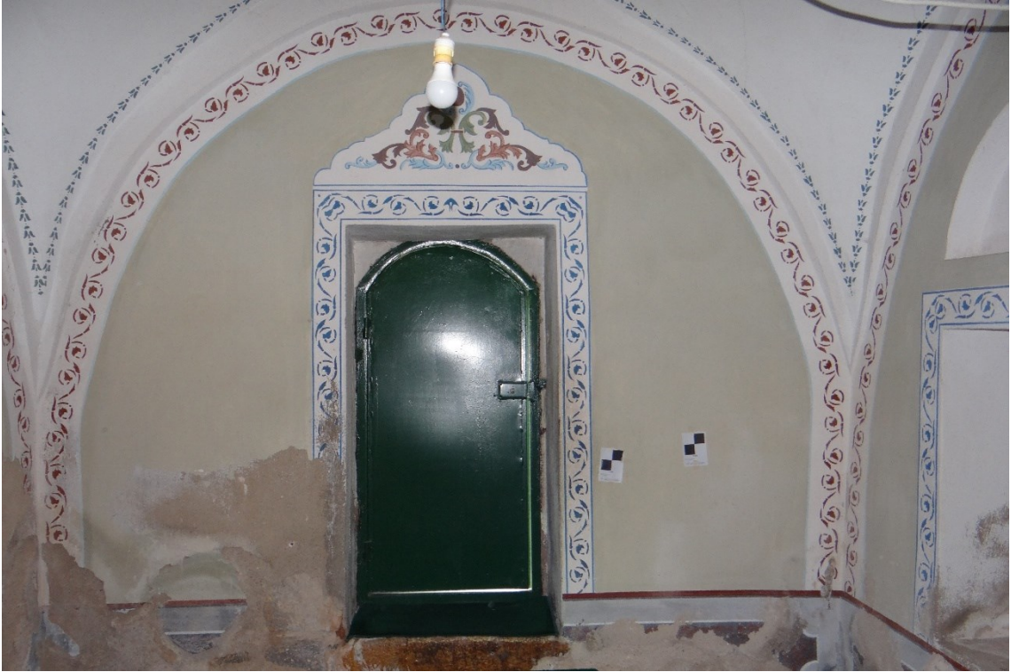
Fotoğraf 14. Ön bölüm kapısı içeriden görünüşü.
