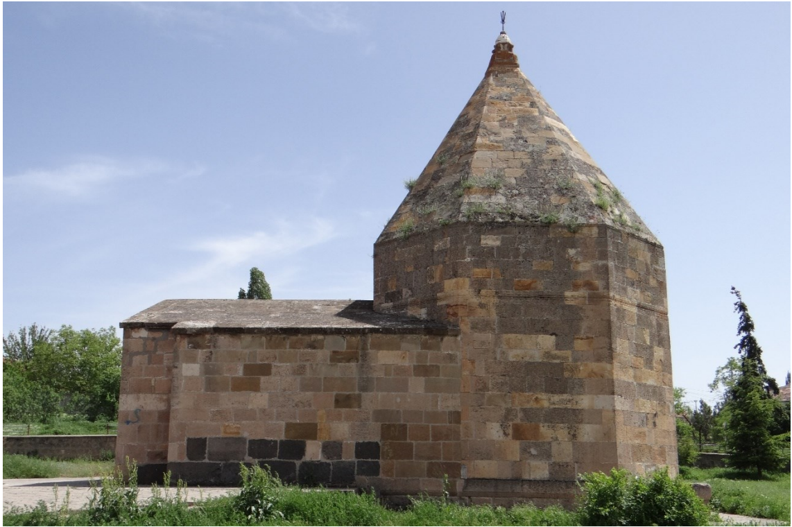
Fotoğraf 8. Kuzey cephe.
