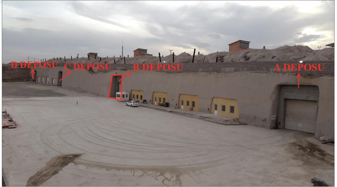
Resim 3.1 Yeraltı soğuk hava deposunun genel dış görünümü
