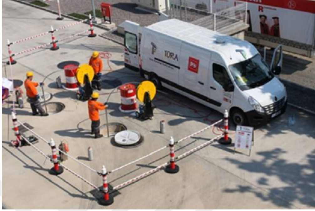
Şekil 4.2. Akaryakıt tank temizliği [47]
