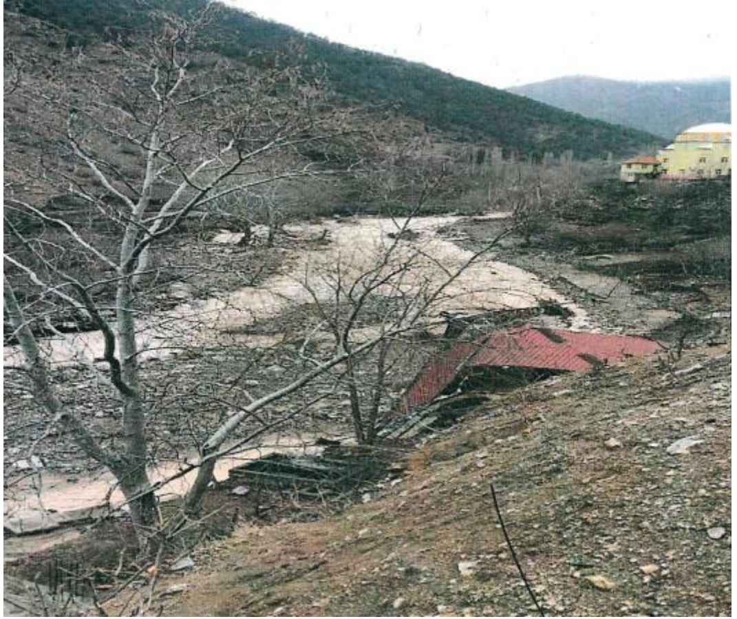
Şekil 4.9. Kapuz Deresi taşkınının atık malzeme sürüklemesi
