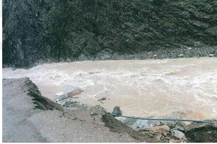
Şekil 4.7. Kapuz Deresi taşkınının toprak, taş gibi atık malzeme toplaması
