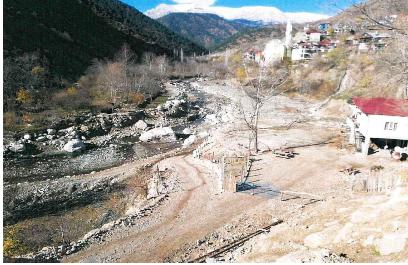
Şekil 4.13. Kapuz Deresi Km:0+000-Km:1+100 arasında,1,100 m dik duvarlı beton kaplama kanal yapılması planlanan güzergah mansaptan menbaya bakış
