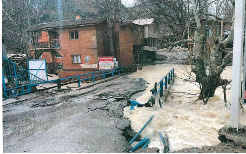
Şekil 4.5. Kapuz Deresinin mahalle içi ulaşım yolundaki tahribatı
