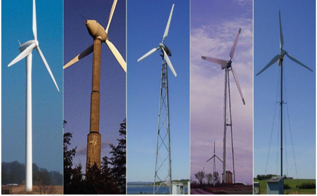
Şekil 2.2. Yatay eksenli rüzgâr türbinleri [42]
